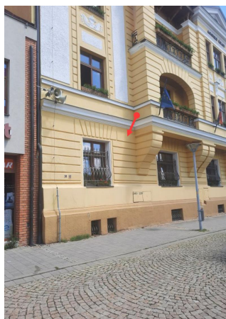
Umiestnenie kamery na budove MsÚ
