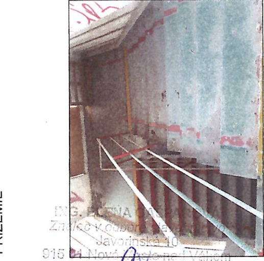
SCHODISKO – POHĽAD Z PODKROVIA
