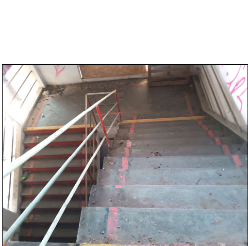
SCHODISKO – POHLAD Z PODKROVIA
